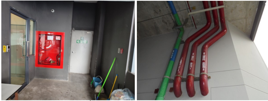
ภาพที่ 3-26 อุปกรณ์ป้องกันและเตือนอัคคีภัย (ต่อ)
