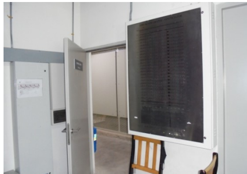
ภาพที่ 3-28 ห้องแจ้งควบคุมสัญญาณเตือนอัคคีภัย
