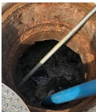
ภาพที่ 3-8 การสูบน้ำจากบ่อบำบัดน้ำเสีย
